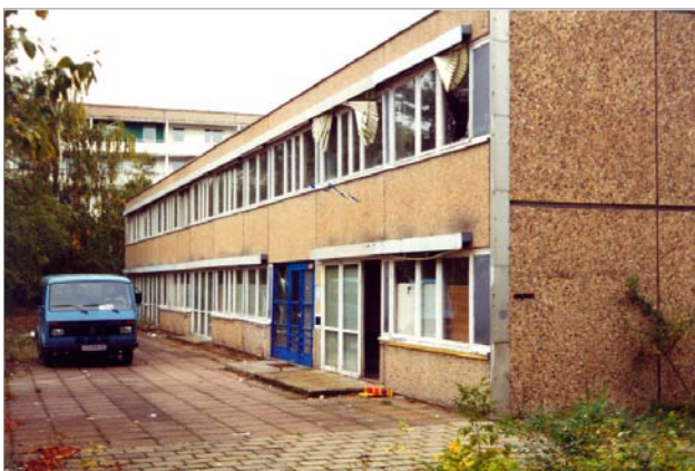
Seitenflügel der Kita vor dem Umbau.
