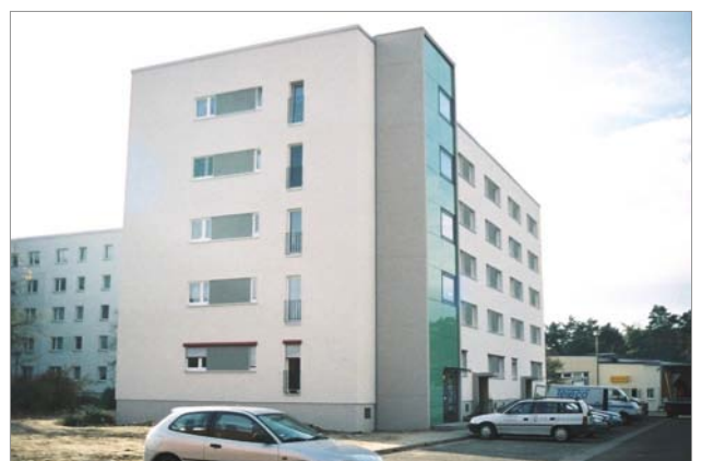
Ein Mix aus unterschiedlichsten Wohnungsangeboten sorgt für eine ausgewogene soziale Mischung im Quartier. 20 Wohnungen wurden altersgerecht umgebaut und sind über neue Aufzüge erschlossen.
