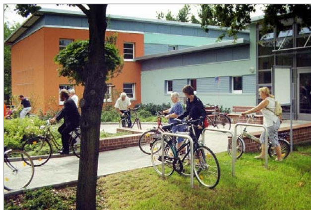
Kita nach dem Umbau: der neue Eingangsbereich
