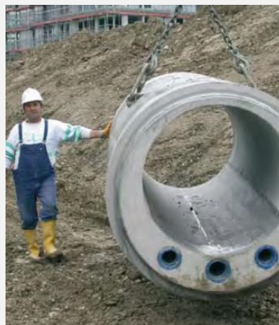
Abb. 75 – Kanalwärmetauscher
