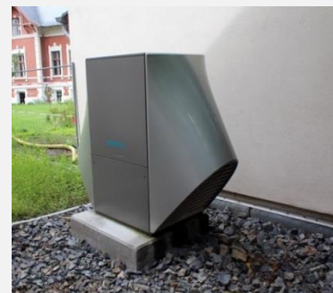
Abb. 44 – Luftwärmepumpe
