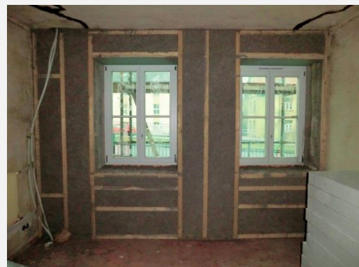
Abb. 61 - Beispiel Zellulose-Innendämmung
