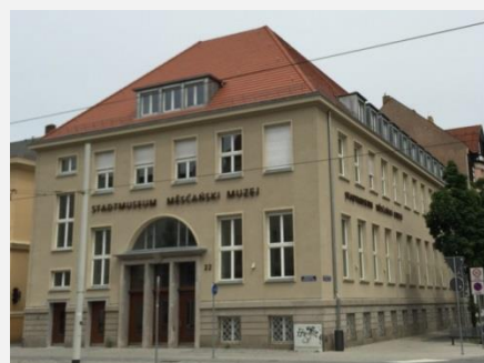
Abb. 67 – Beispiel kommunales Gebäude
