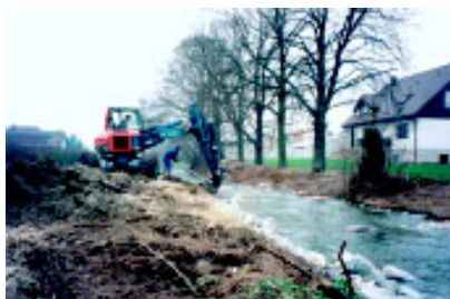
Bau Sohlgleite Priorgraben (2001)
