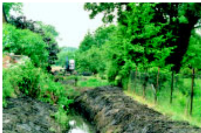
Grundräumung Ströbitzer Landgraben (2001)
