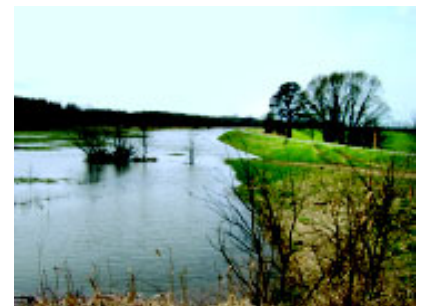
Hochwasser 2006: Dissener Brücke
