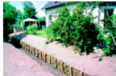
Ufersicherung Ströbitzer Landgraben (2001)
