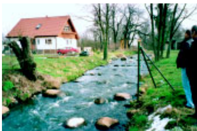
Endzustand Sohlgleite Priorgraben (2001)
