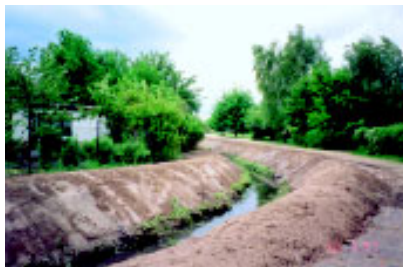
Uferverwallung Zahsower Landgraben (1997)
