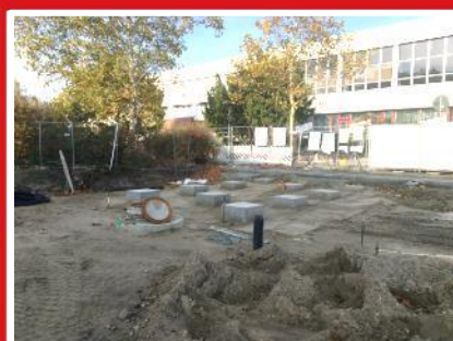
Fundamente Fahrradabstellanlage Oktober 2018
