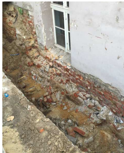
Freilegung erdberührter Bereiche
