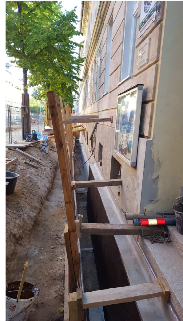
Abdichtungsarbeiten
