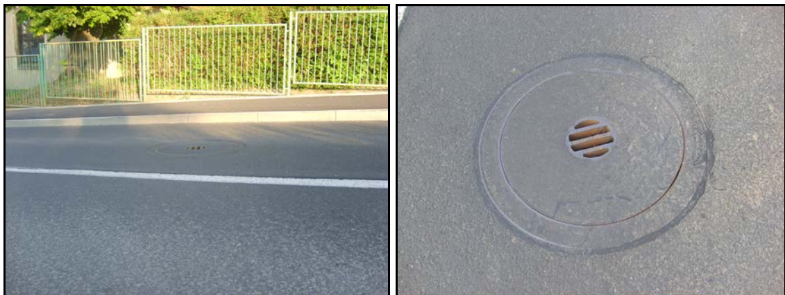
Abb. 38 Lärmarme Schachteindeckung (Beispiel Dresden)
