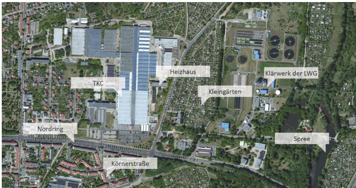
Abbildung 48 Luftbild mit Kennzeichnung der Anlagen (Google, eigene Angaben)
