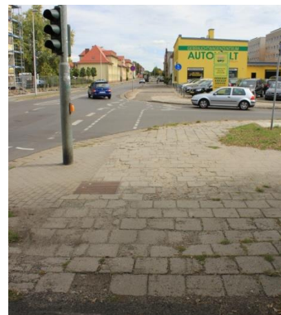
Abbildung 33 Geh-/ Radwegschäden Dissenchener Straße
