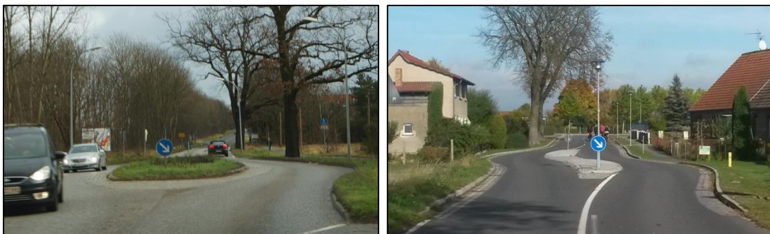
Abb. 27 Beispiele Ortseingangsgestaltung mit Fahrstreifenversatz
